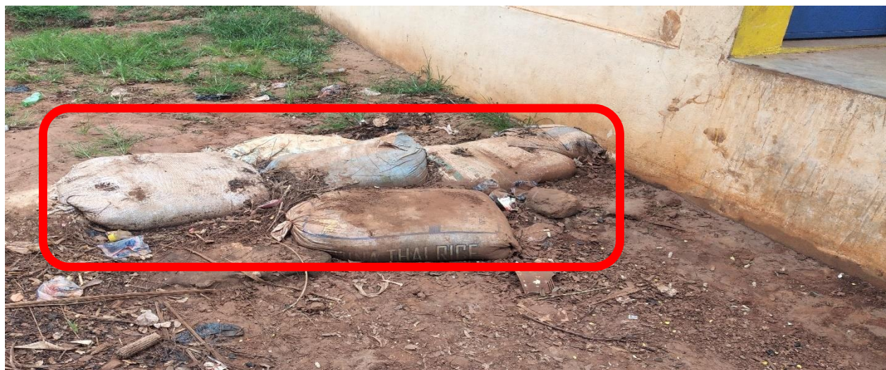
Dispositif de lutte contre l'érosion pluviale mis en place par les élèves du club d'enfant de l'EPP Tsévie-Wémé
